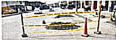
Señalización Av. 25 de Agosto, reparación fuga de agua notable en el collarín de la red matriz 110ml
